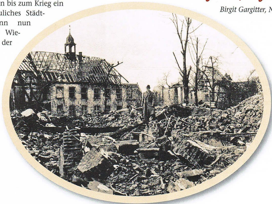
Das Ende und der Anfang: Der Dinslakener Baurat Heinrich Nottebaum steht auf den Trümmern des Voswinkelshof.
